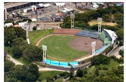
藤崎台県営野球場(熊本市)
